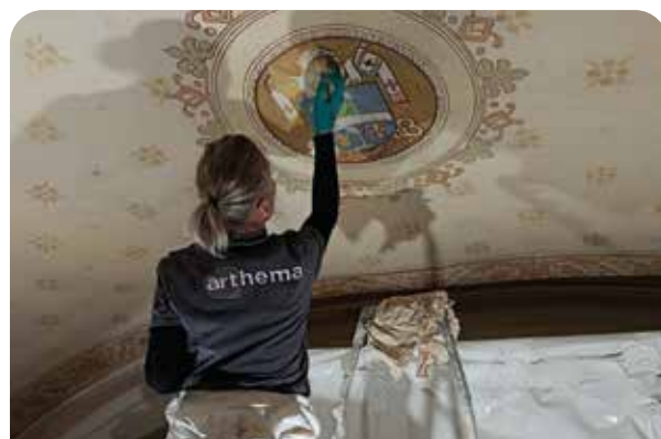
L'entreprise Arthema lors de la rénovation des décors muraux.
