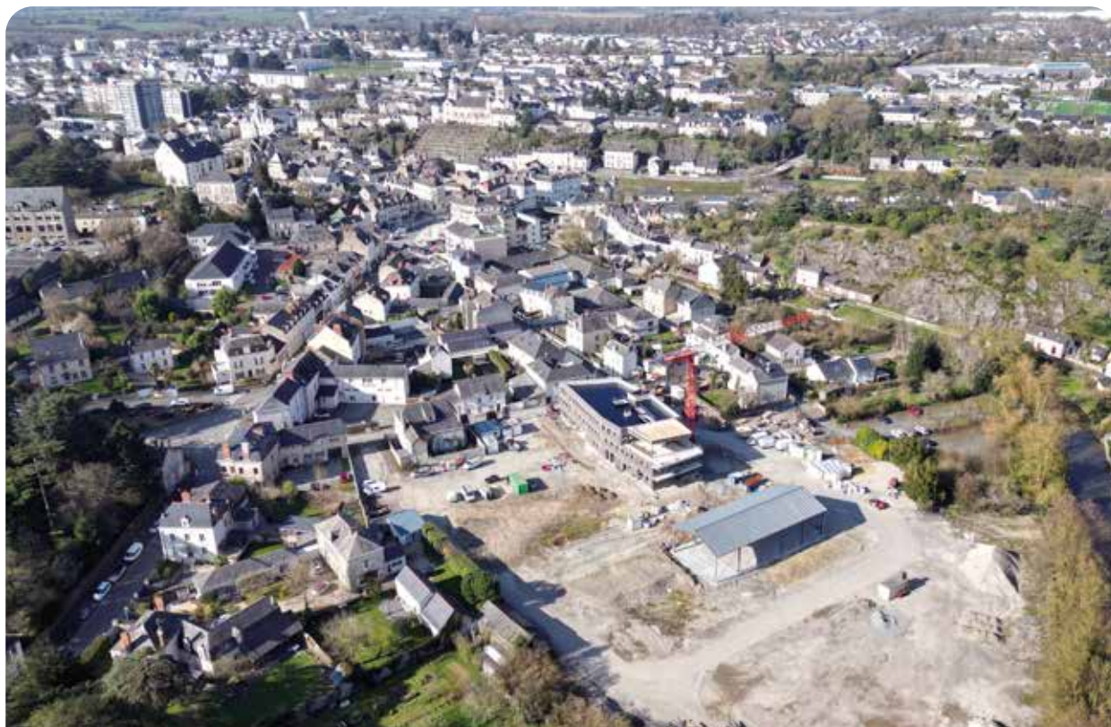
Vue du chantier au 3 mars 2025. Crédit photo: Anjou Bleu Communauté
