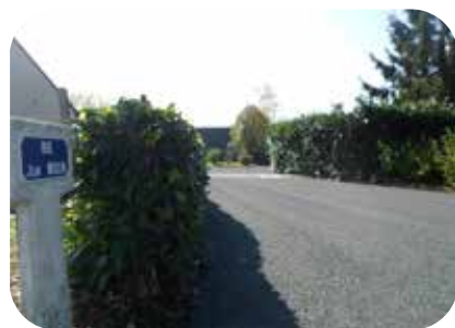
Rue Jean Moulin, travaux de voirie
